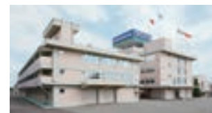
鳥栖工場 当社発祥の地にある生産拠点で、貼付剤を生産しています。
