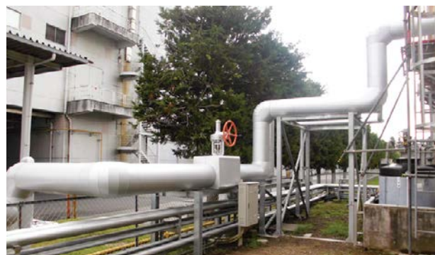
▲本センターより排出された蒸気を久光製薬の敷地内へ
