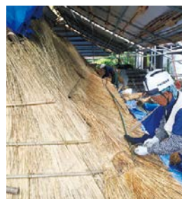
久野邸茅葺屋根葺き替え工事
